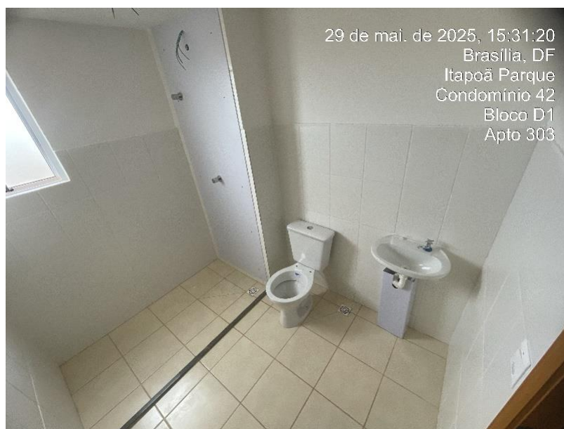
Figura 16 – Unidade habitacional pós serviços de acabamento realizados – Banheiro, com shaft visitável para manutenção das instalações. Fonte: O Autor (2025)
