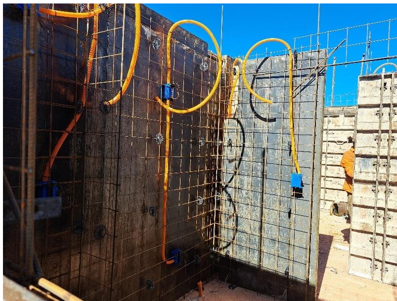
Figura 11 – Execução de estrutura: Posicionamento de fôrmas metálicas e incorporação de eletrodutos e caixas de passagem. Fonte: O Autor (2025)
