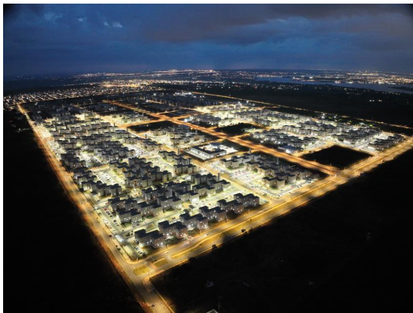
Figura 25 – Vista geral noturna do empreendimento, com destaque para a 1ª Etapa entregue Fonte: JC GONTIJO ENGENHARIA (2025)
