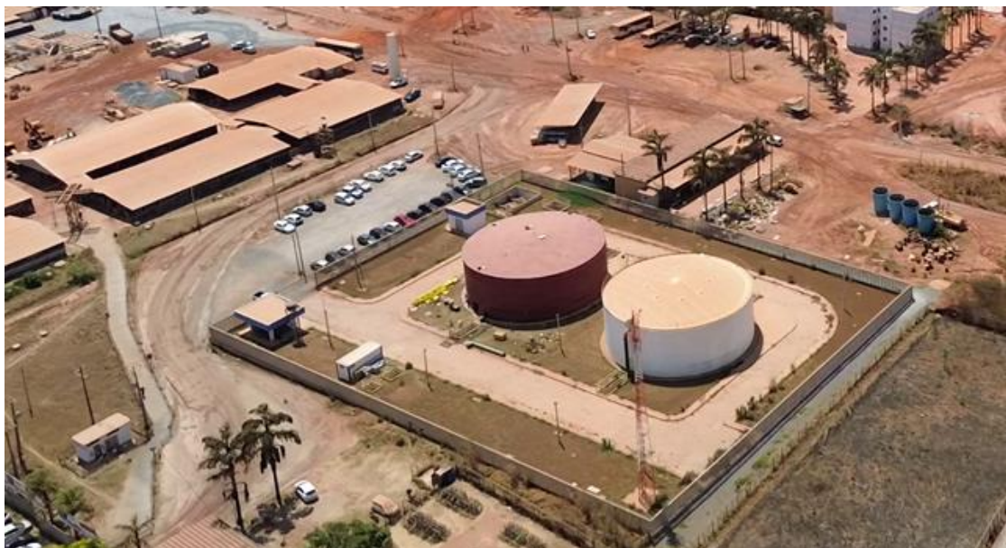
Figura 23 – Reservatório de Apoio (RAP) Itapoã. Fonte: JC GONTIJO ENGENHARIA (2025)
