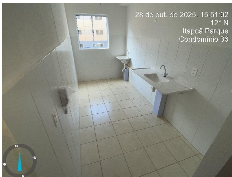
Figura 15 – Unidade habitacional pós serviços de acabamento realizados – Cozinha e área de serviço. Fonte: O Autor (2025)
