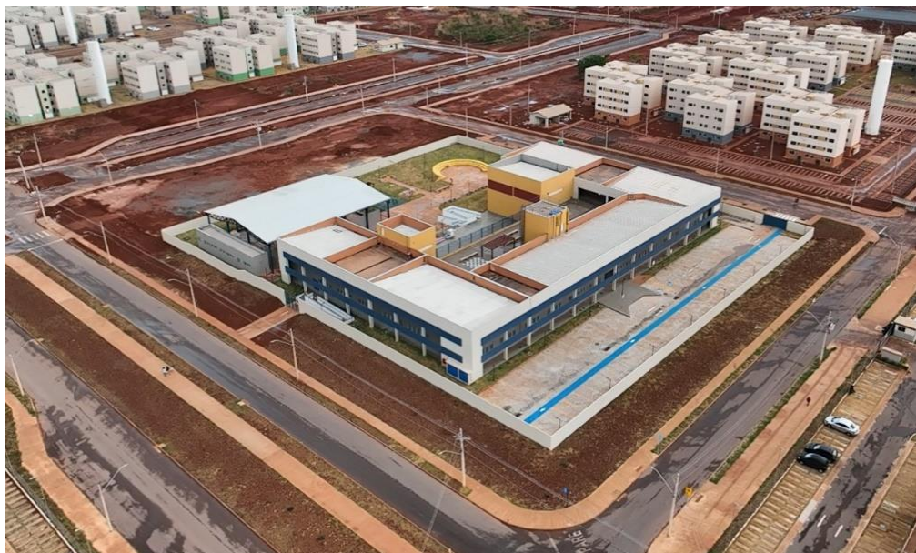
Figura 29 – Vista aérea da Escola Classe 401 em fase final de execução. Fonte: JC GONTIJO ENGENHARIA (2025)
