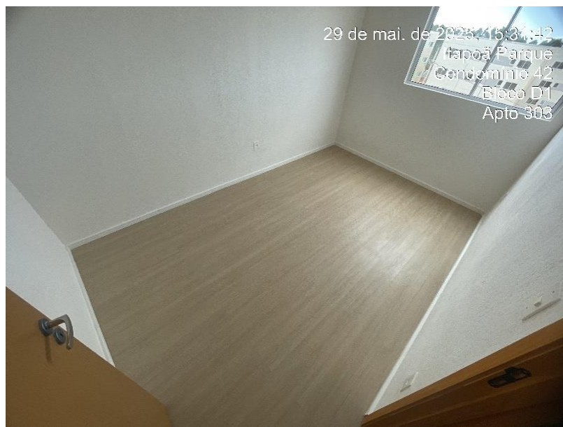
Figura 17 – Unidade habitacional pós serviços de acabamento realizados – Dormitório. Fonte: O Autor (2025)
