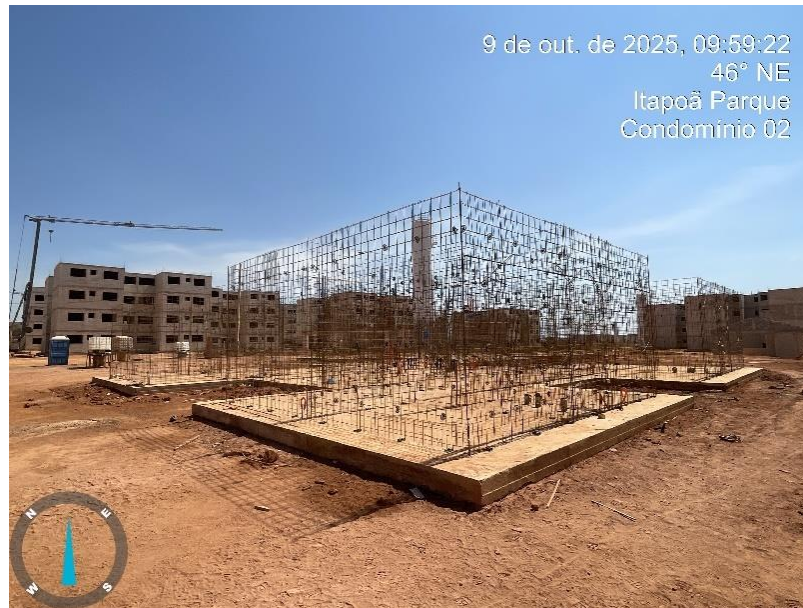
Figura 9 – Execução de estrutura: Radier executado, com posicionamento de tela metálica eletrossoldada. Ao fundo guindaste que posiciona as fôrmas metálicas. Fonte: O Autor (2025)
