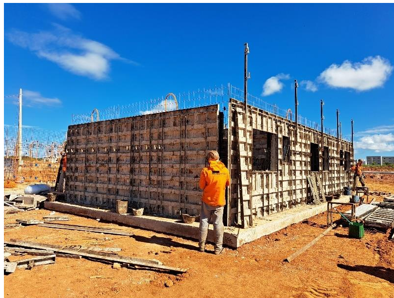
Figura 10 – Execução de estrutura: Posicionamento de fôrmas metálicas. Fonte: O Autor (2025)
