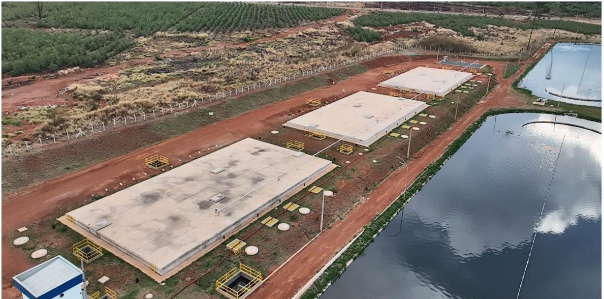
Figura 21 – Vista aérea da Estação de Tratamento de Esgoto ampliada. Fonte: JC GONTIJO ENGENHARIA (2025)
