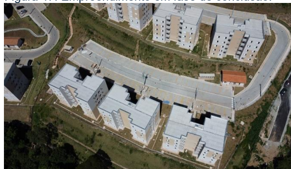
Figura 47: Empreendimento em fase de conclusão.
