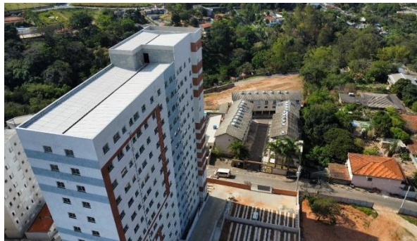
Figura 48: Obra finalizada com ausência/divergência de revestimento externo na cobertura.
