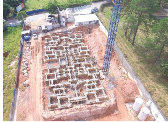
Figura 27: Registro com RPAS da finalização de concretagem dos blocos e vigas da fundação.
