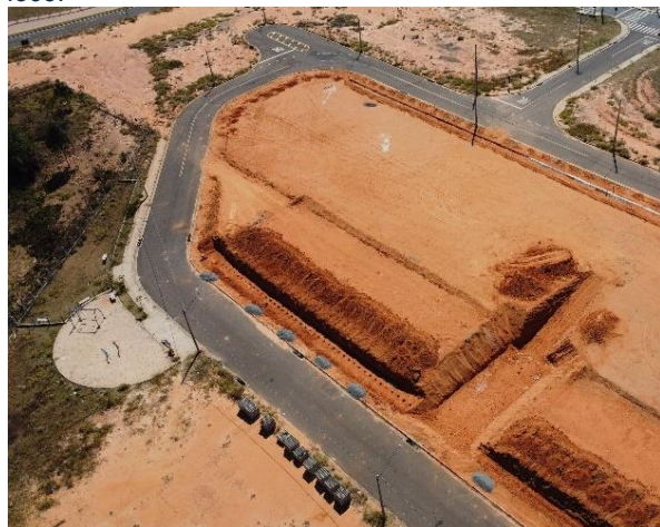
Figura 12: Serviço de terraplenagem executado in loco .
