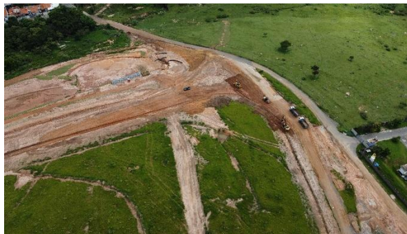
Figura 17: Obras não incidentes do empreendimento em fase inicial.
