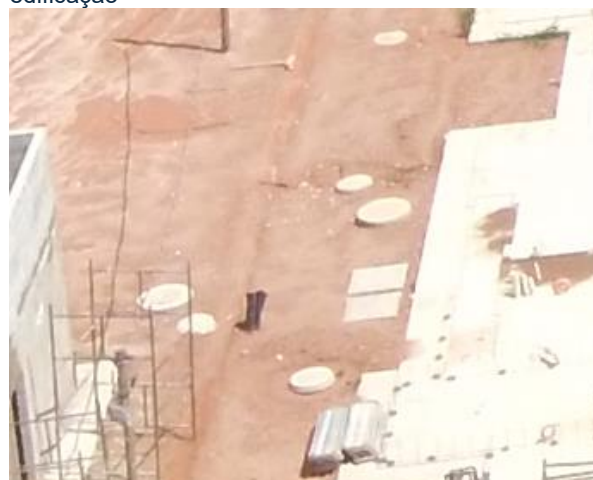
Figura 31: Detalhes de caixas de gorduras e de inspeção de esgoto junto ao embasamento da edificação
