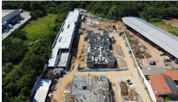
Figura 43: Execução de edifício garagem em etapa inicial de execução.
