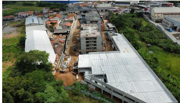
Figura 44: Execução de edifício garagem em etapa de conclusão de execução.
