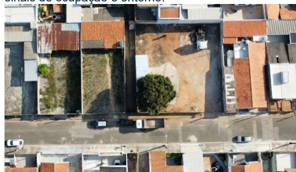
Figura 7: Vista geral de terreno proposto MCMV com sinais de ocupação e entorno.
