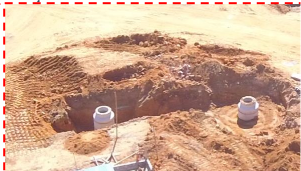
Figura 29: Detalhe de registro da rede de drenagem em execução
