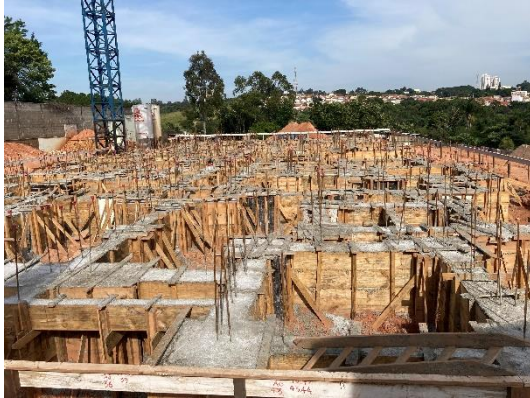
Figura 26: Registro usual da finalização de concretagem dos blocos e vigas da fundação
