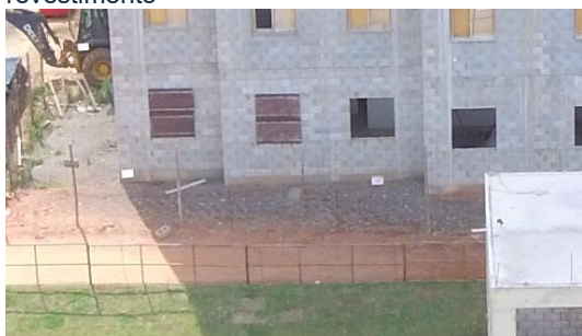
Figura 37: Edificação em obra ainda sem revestimento
