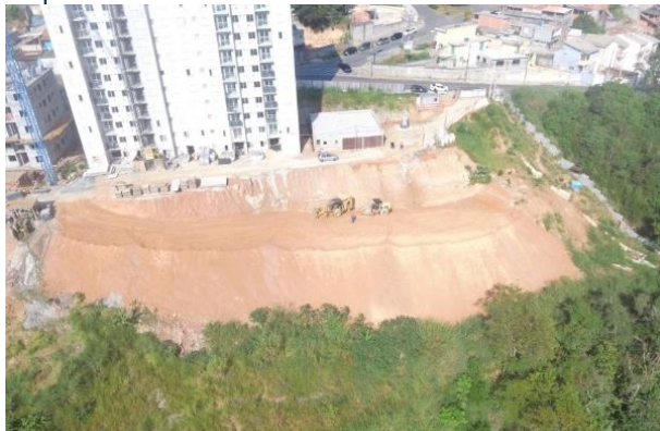
Figura 16: Serviço de terraplenagem junto a talude de empreendimento realizado de forma convencional.
