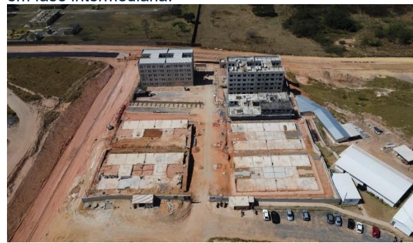
Figura 33: Obras não incidentes do empreendimento em fase intermediária.
