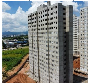
Figura 36: Execução de torre com a concretagem da estrutura finalizada (foto de 13/02/25).
