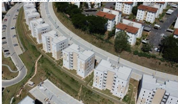
Figura 46: Empreendimento em fase de conclusão.
