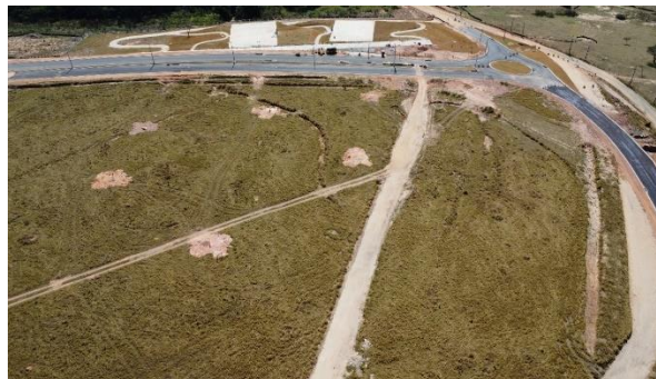
Figura 18: Obras não incidentes do empreendimento em fase intermediária.
