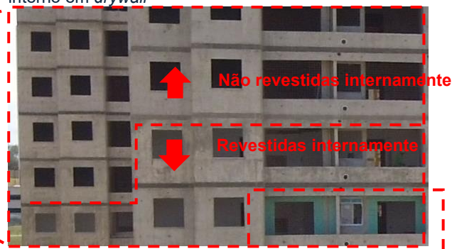
Figura 42 - Detalhe de registro geral onde é possível identificar unidades que receberam/não receberam revestimento interno e a execução de fechamento interno em drywall
