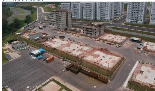
Figura 32: Obras não incidentes do empreendimento em fase inicial.
