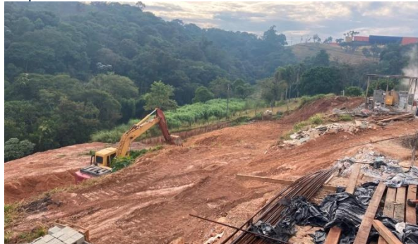
Figura 14: Serviço de terraplenagem junto a talude de empreendimento realizado de forma convencional.
