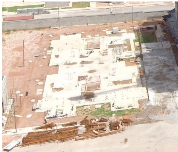
Figura 30: Vista geral da laje térrea da edificação em execução
