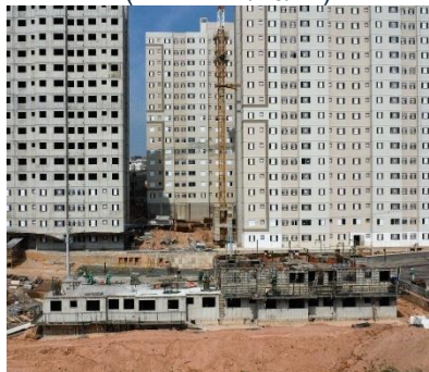
Figura 34: Execução de torre com a concretagem do pavimento térreo finalizada (foto de 17/10/24).
