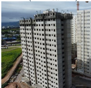
Figura 35: Execução de torre com a concretagem do 16º pavimento finalizada (foto de 05/12/24).
