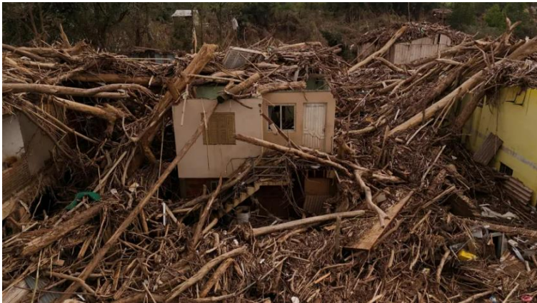
Figura 7: Uma vista de drone mostra uma casa danificada coberta por troncos e galhos de árvores após as enchentes do rio Taquari em Arroio do Meio Fonte: https://noticias.uol.com.br/cotidiano/ultimas-noticias/2024/05/25/mortes-enchente-rio-grande-do-sul.htm
