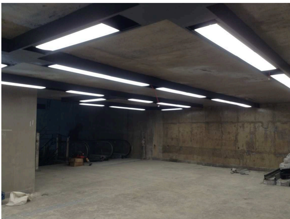
Foto 3 – Túnel de acesso à Linha 5 – Lilás
