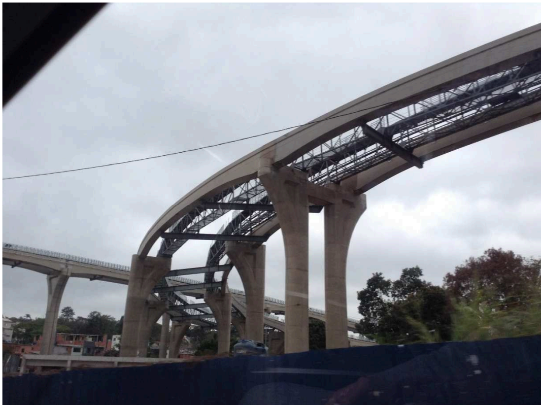
Foto 8 – Via elevada – enlace
